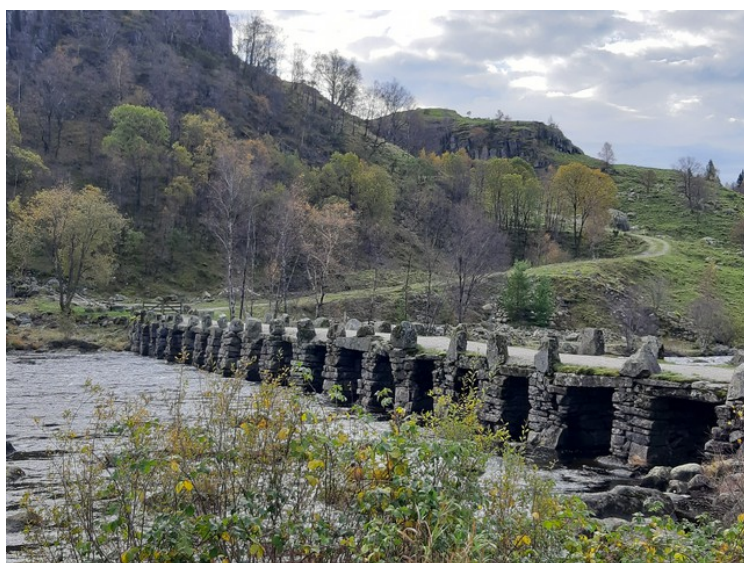
Dette er Terland klopp . Det er en steinhellebro som ble bygget rundt 1800. Den har stabbesteiner til rekkverk. Med sine 21 løp og ei lengde på 60 meter, er den regnet som den største i Norden i sitt slag. Den ble fredet av Riksantikvaren i 2008.
